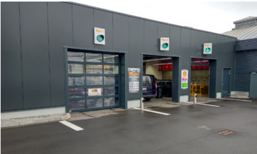
Drei Boxen am Standort Reinickendorf – Einfahrtseite
